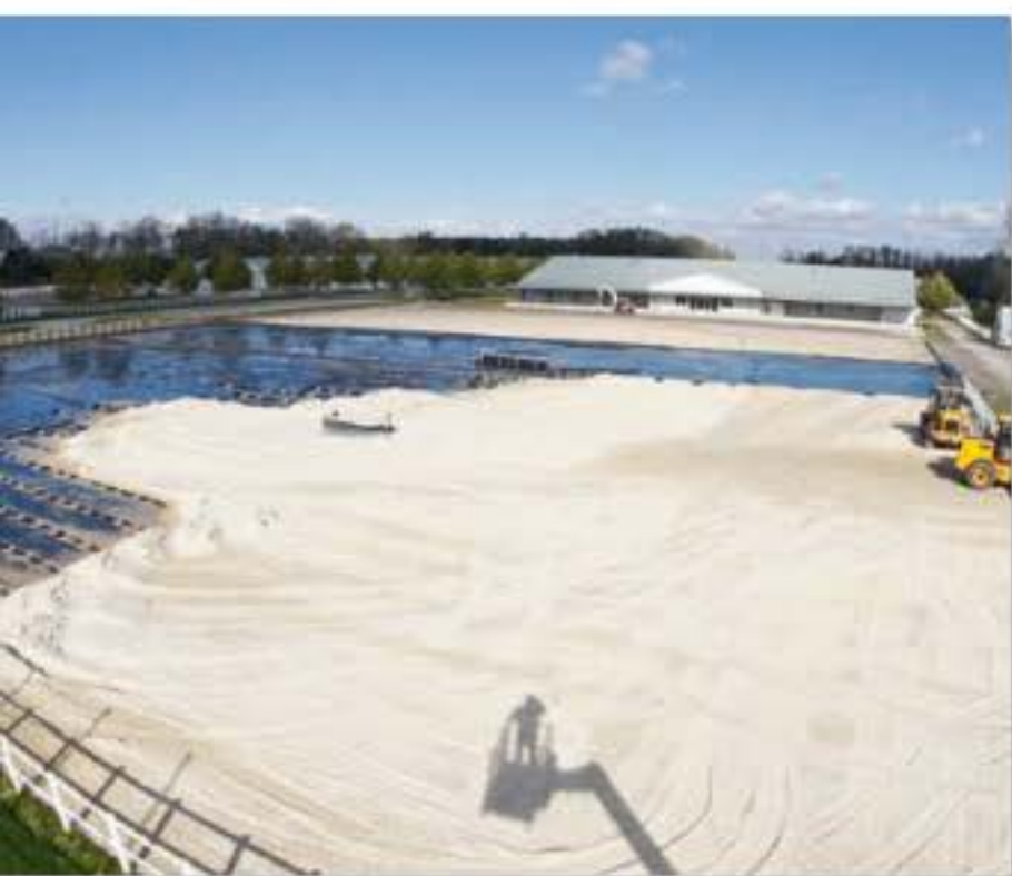
Der neue Grand Prix-Platz wurde mit einem Ebbe-Flut-System ausgestattet, das sich bereits bewährt hat.
