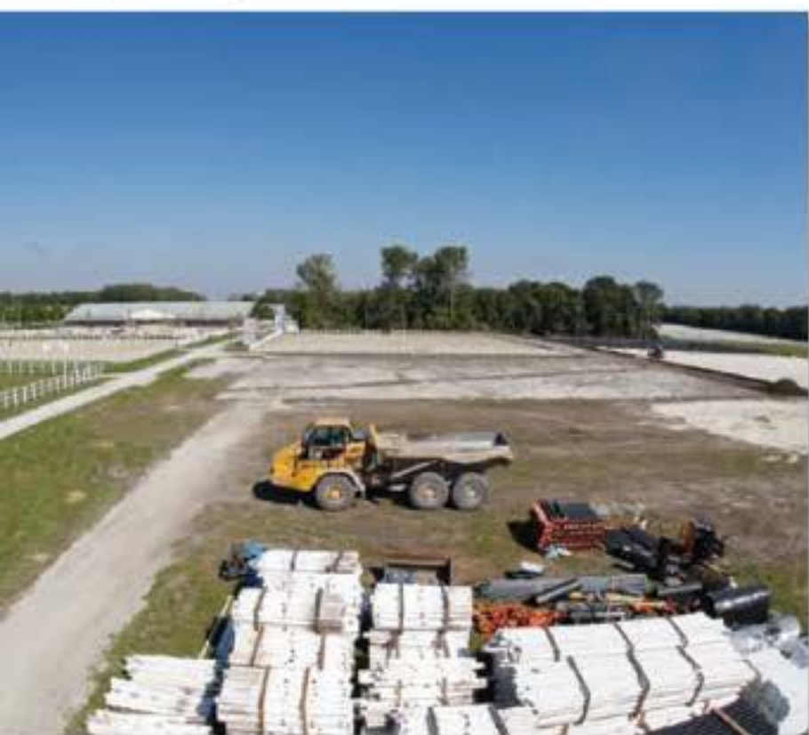
Die neuen Springplätze kurz vor der Fertigstellung.
